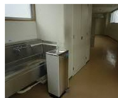
冷水器の新設
